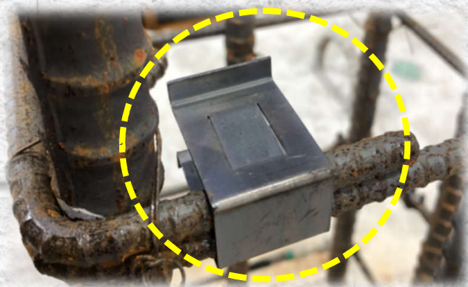
원터치-RC클립 1개 설치 모습
