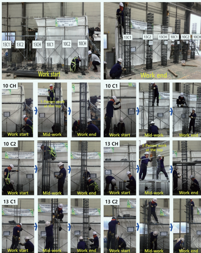
[그림 7.3] 각 Mock-up 기둥 단계별 작업 사진
